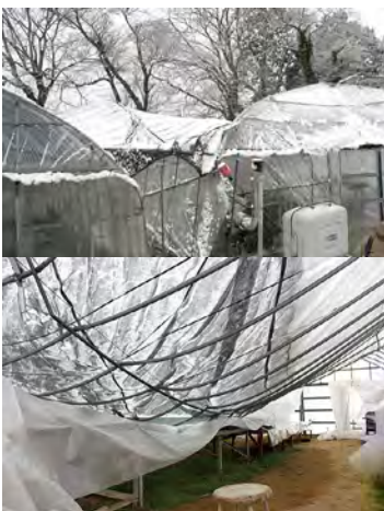
大雪で倒壊してしまったハウス。ワスレナグサが押しつぶされていた。
